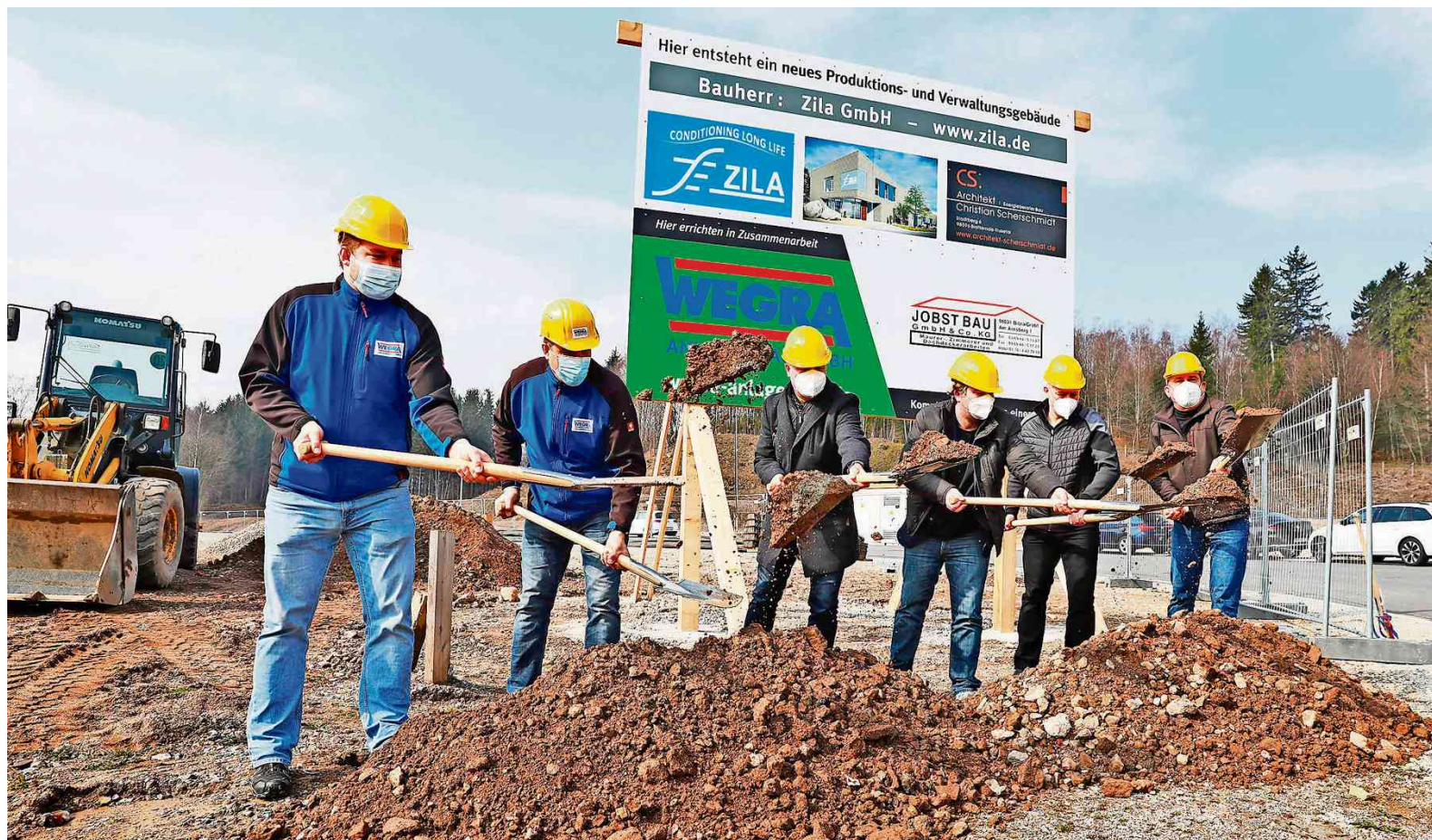
Gemeinsam legen sie Hand an: Christian Kemmerzahl und Gregor Weidner von der Wegra Anlagenbau GmbH sowie die Bauherren Frank und Steffen Wiedmann von der Zila GmbH, Architekt Christian Scherschmidt und der Zella-Mehliser Bürgermeister Richard Rossel (von links). Fotos: Michael Baurtoth
