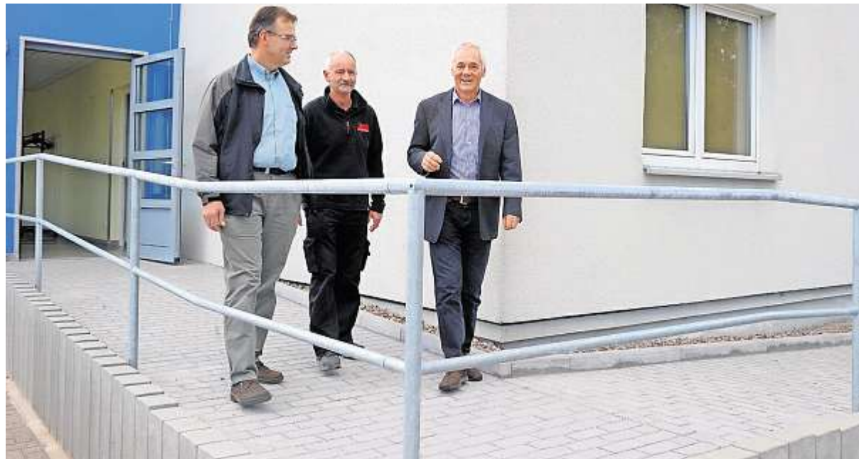
Gemeinsam mit den Handwerksmeistern Tobias Döll und Matthias Walther (von links) begutachtete der Geschäftsführer des BCS, Horst Gerlach (rechts), die neue Rampe für Rollstuhlfahrer, die am Gästehaus entstanden ist. Foto: frankphoto.de
