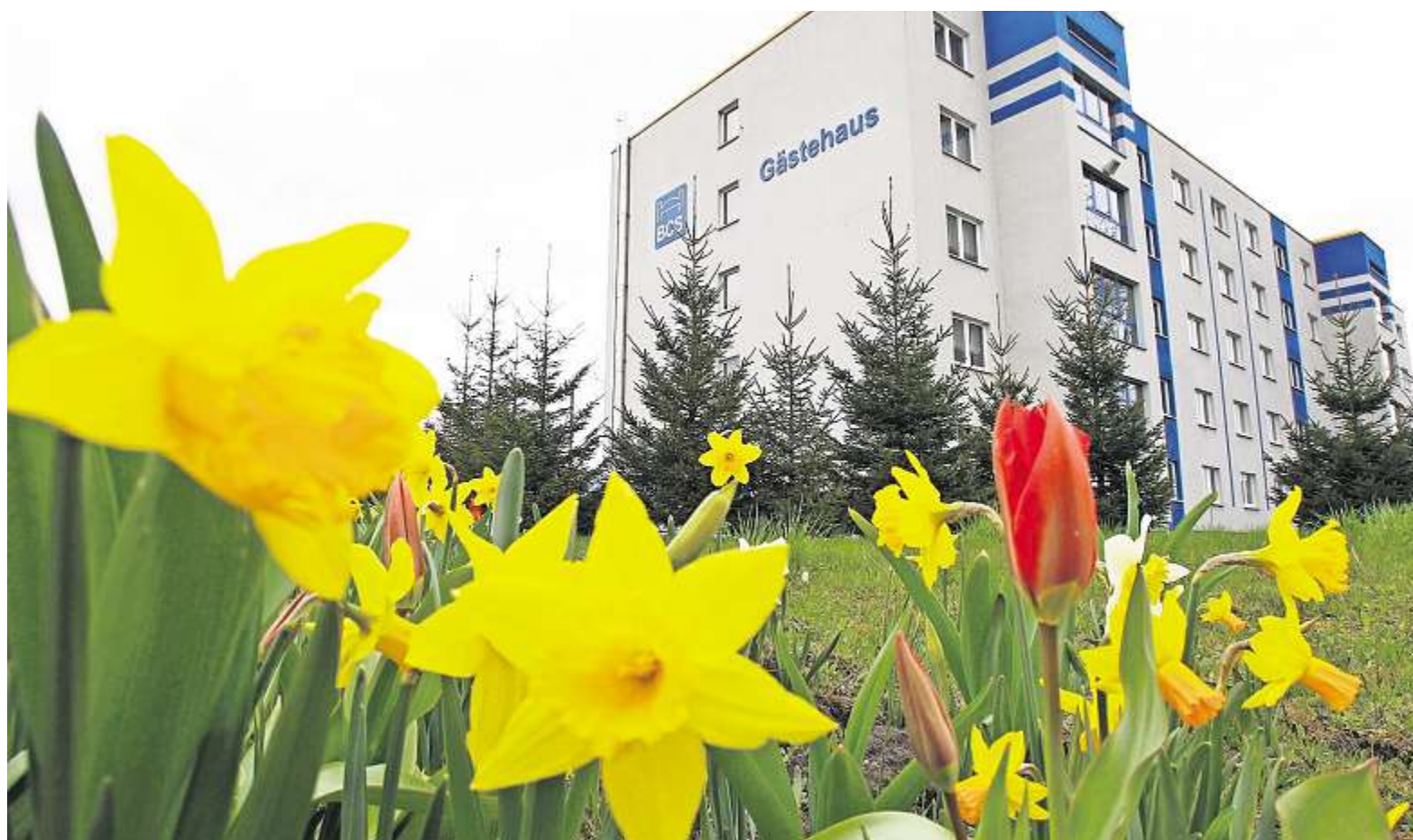
1976 errichtete das EGS ein Wohnheim für Schichtarbeiter, ausländische Arbeitskräfte und Lehrlinge. 1990 übernahm der Landkreis das Gebäude zur Unterbringung von Berufsschülern. Inzwischen gehört das Haus dem Bildungs-Center Südthüringen, es wurde saniert und zum Gästehaus umgebaut. Foto: Baurath
